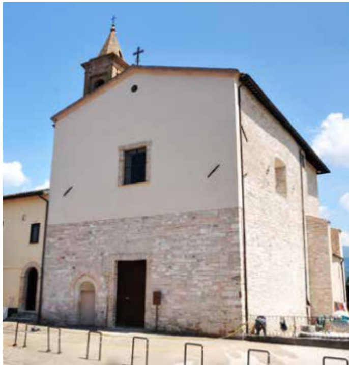
Chiesa s. Egidio in Borroni Foligno (PG): Lavori di consolidamento della volta, del campanile e della copertura. Diocesi di Foligno
