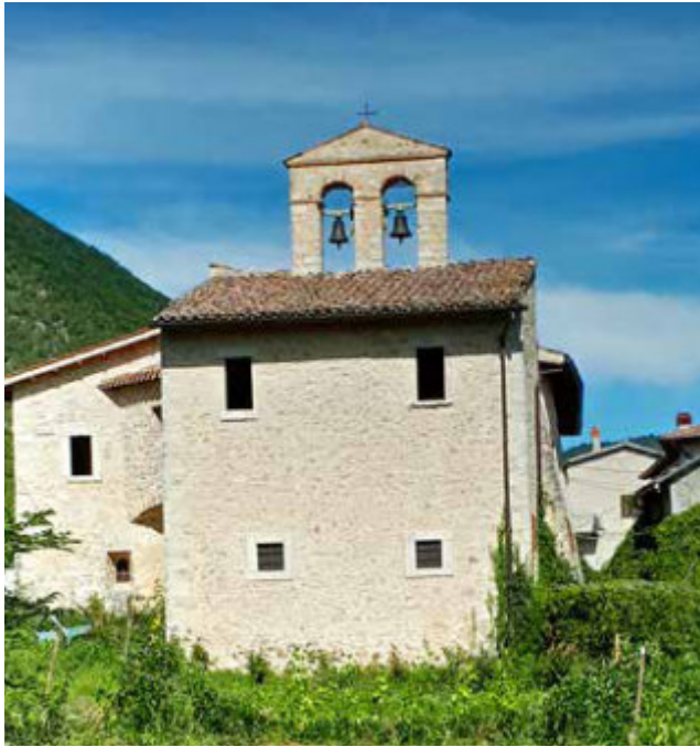
Chiesa S. Giovanni Battista Fraz. Giappiedi di Cascia (PG) Lavori di consolidamento della volta e rifacimento della copertura. Archidiocesi Spoleto-Norcia
